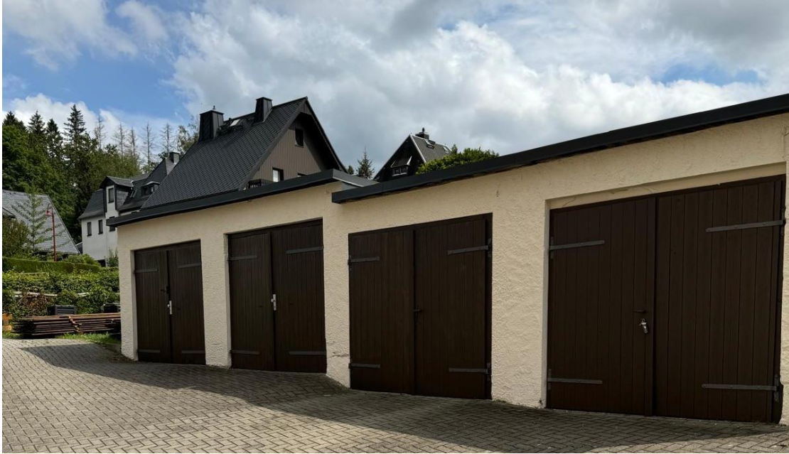
Garagen im Innenhof
