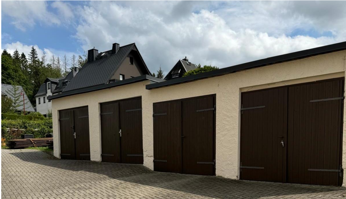
Garagen im Innenhof
